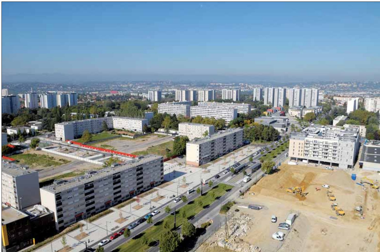
À gauche, le quartier Armstrong, désormais bordé d'une large esplanade le long de l'avenue Jean-Cagne, et traversé dans le sens nord-sud par un mail piétonnier. À droite, Vénissy, où les travaux d'aménagement de la place centrale ont commencé.
